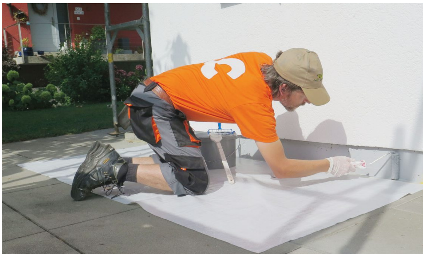
Contact Travail offre aux personnes dépendantes des petits jobs, comme ici une rénovation de façade. AUDE ZUBER
